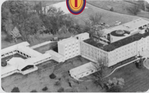
Extensão das obras, em 1967.
